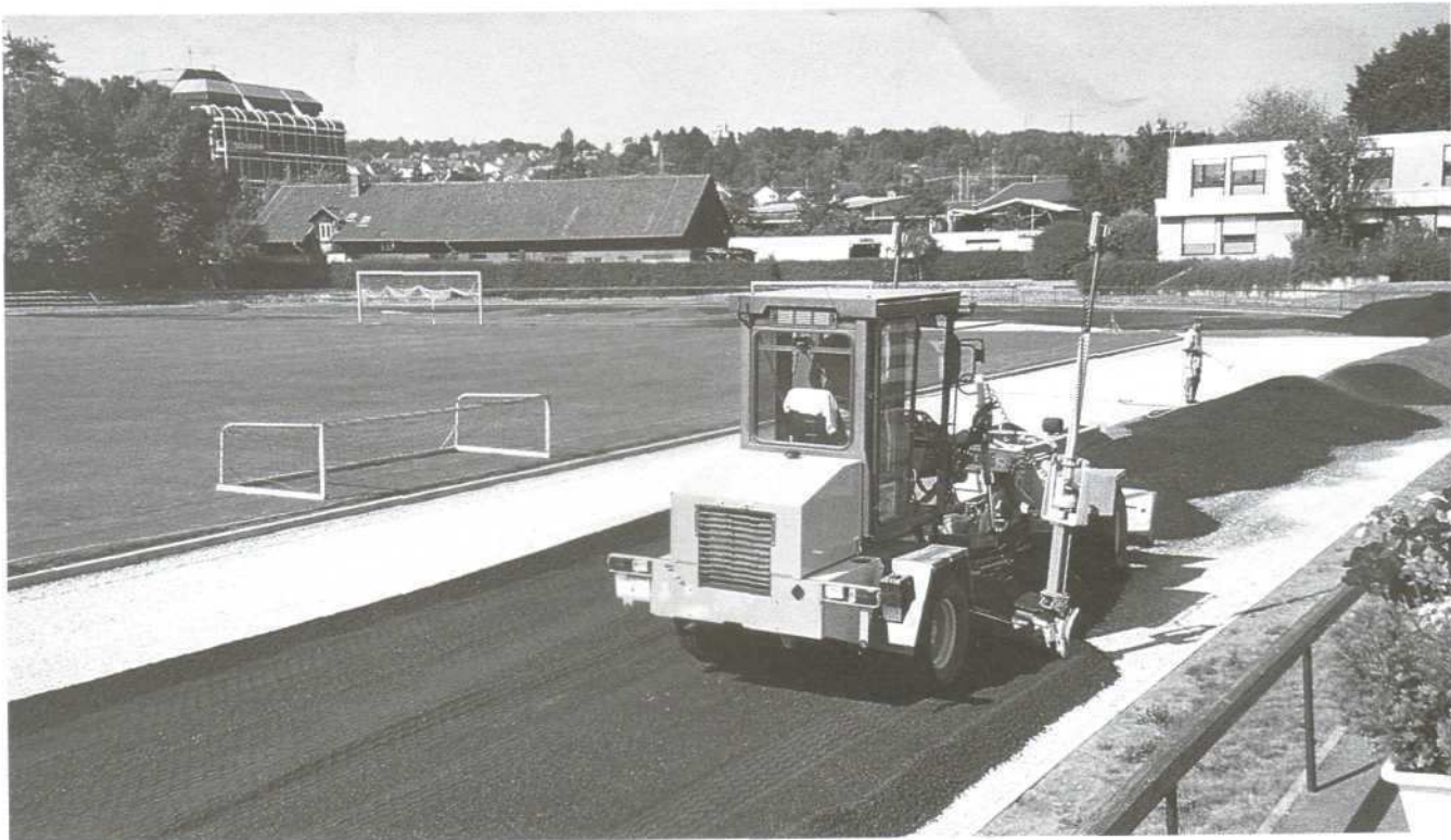
Zwischendurch wurden die Arbeiten an der Aschenbahn vorangetrieben. Aufbereitung der unteren Schicht mit grobkörniger Asche.
