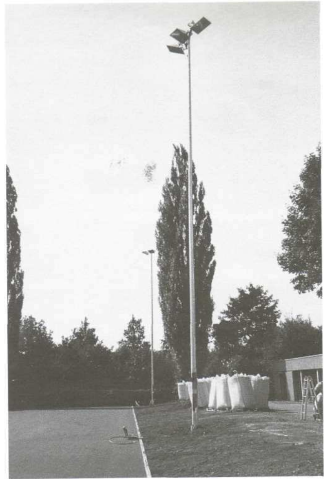
Nun ging es daran, die 6 neuen Flutlichtmasten zu setzen und auszurichten.
