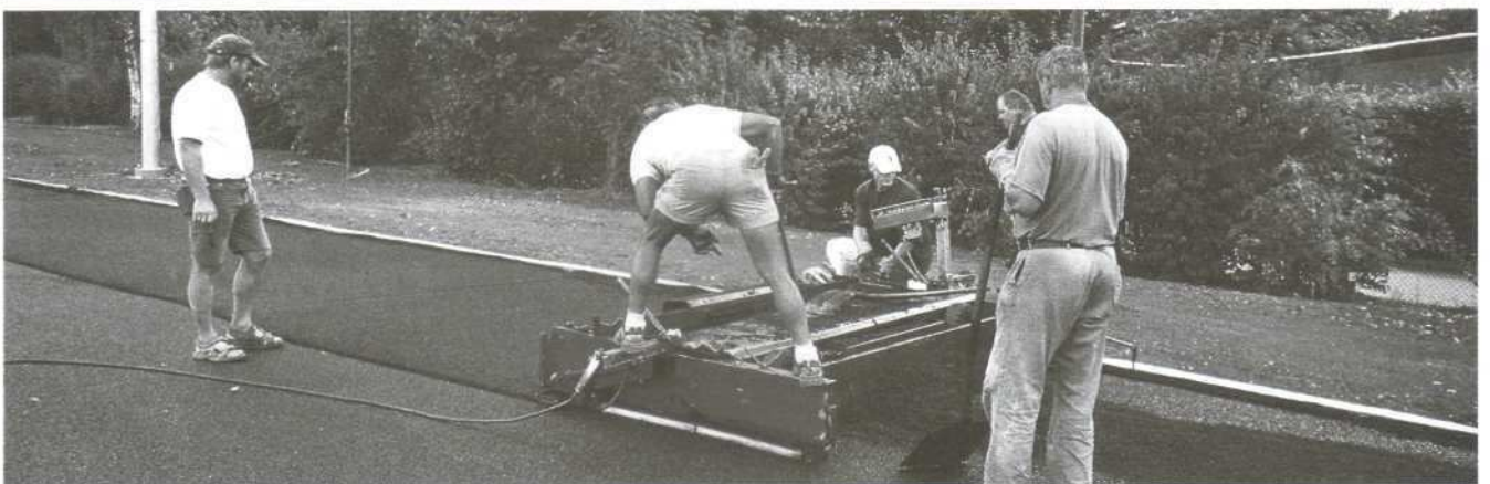
Nach der Schotter- und der ungebundenen Tragschicht und dem Setzen der Spieleinfassung aus Betonbordsteinen wird die gebundene, elastische Tragschicht aufgebracht. Auf diese kommt später dann der Kunstrasen. Gleichzeitig erfolgt die Verlegung der Stromkabel für das Flutlicht.
